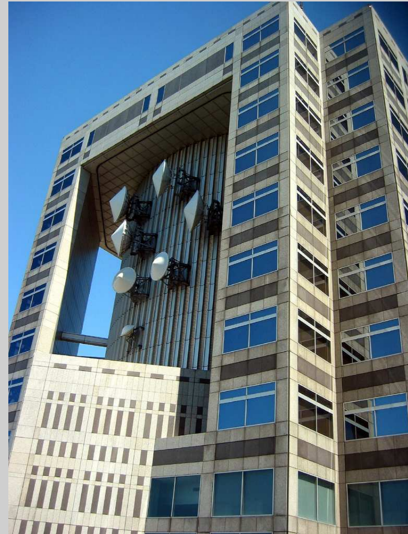
VISTA DIURNA DEL EXTERIOR DEL EDIFICIO.
