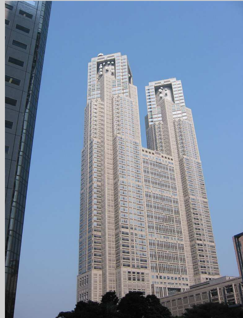
VISTA DIURNA DEL EXTERIOR DEL EDIFICIO.
