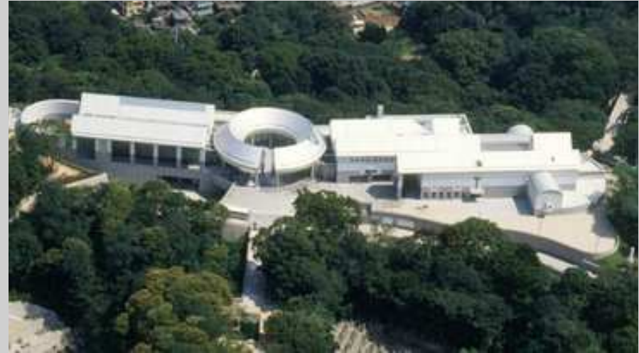
VISTA AÉREA DEL COMPLEJO Y ZONA DE CONTEXTO.
