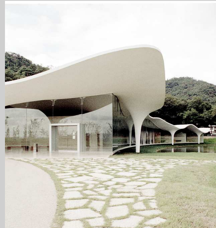
VISTA EXTERIOR DEL EDIFICIO.
