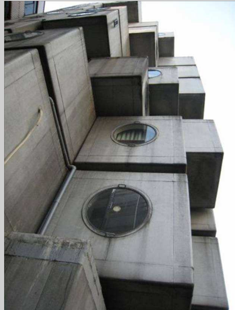
VISTA EXTERIOR DE CÁPSULAS DE ASBESTO Y CONCRETO.
