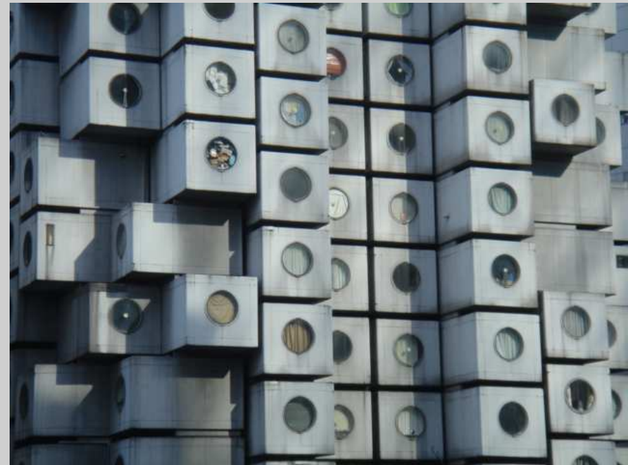
VISTA EXTERIOR DEL EDIFICIO, DINAMISMO DE CÁPSULAS.
